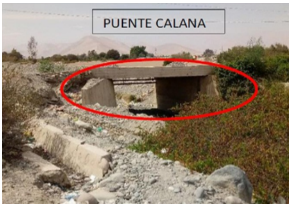
Figura 3: Vista frontal del puente Calana, material del presente caso aplicativo.
